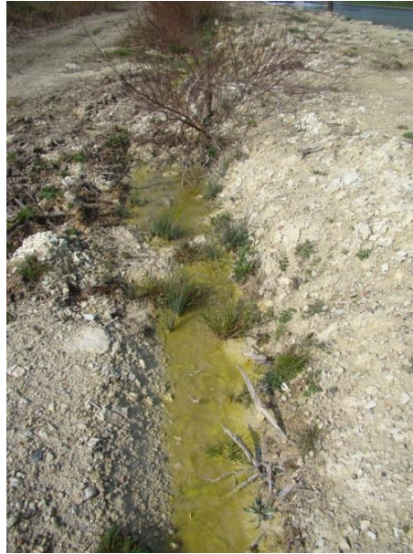
Figure 8 : Fossé après travaux par VNF – Avril 2015 – B. DEROLEZ
