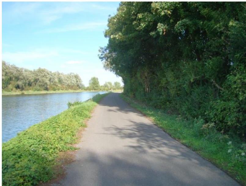
Figure 29 : Partie est du corridor – Août 2017 – S. RONDEL
